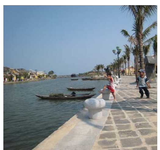
Varma dagar flyter Thu Bon floden fram som en svalkande bris genom staden Hoi An. På den norra banken ligger stadens gamla kvarter och på södra sidan pågår arbetet med att höja kajkanten som skydd mot årligen återkommande översvämningar. I samband med kajhöjningen skapas nu en lång och bred strandpromenad, som även rymmer en internationell skulpturpark. Hoi An har fått en ny sida att visa upp.
